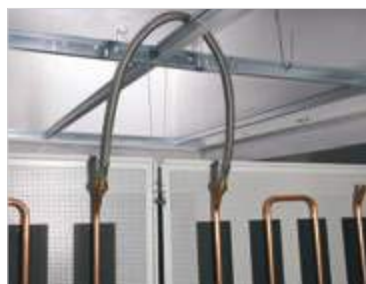
Particularidade da ligação em série de duas placas contíguas
