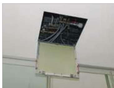
Inspecionabilidade do teto radiante em cartão gesso
