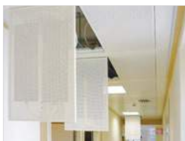
Inspecionabilidade do teto radiante metálico
